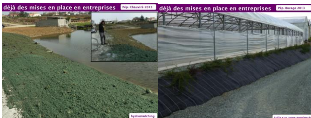
Photo 6 : Enherbement d'une réserve d'eau par hydromulching (Pépinières de L'Evre)
