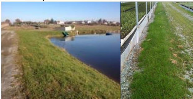
Photo 16 : Enherbement d'une réserve d'eau par hydromulching, un an après (Pépinières de L'Evre)
